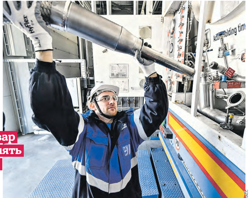
Специалист с гибкими металлорукавами работает в логистическом центре газоперерабатывающего завода компании «Газпром» в Приморском крае
