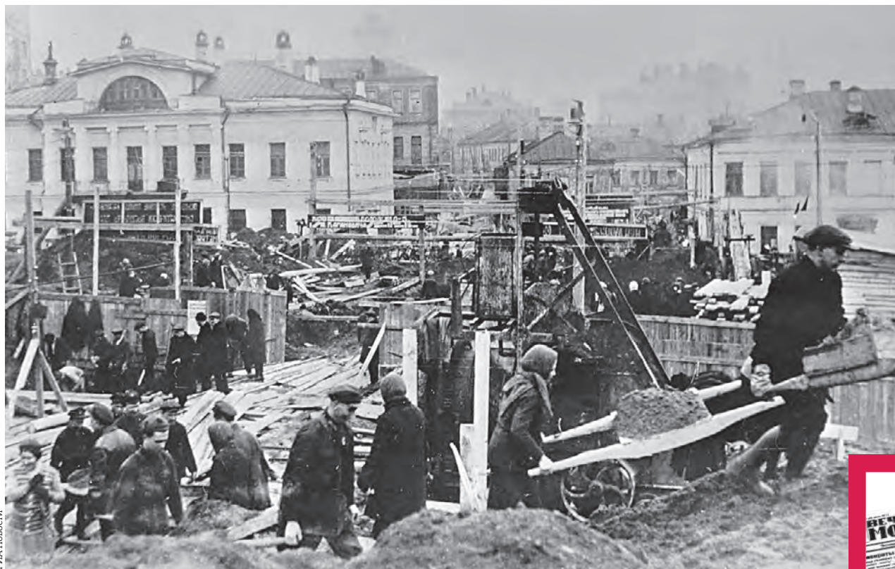
1934 год. Рабочие лесопильного завода № 1 имени Ильича трудятся на субботнике по строительству Московского метрополитена в районе Волхонки
